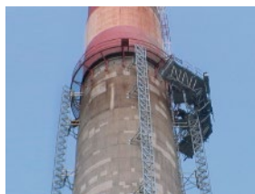
煙突解体工事
